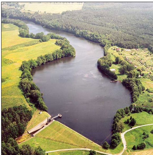
Fot. 3. Stopień wodny w Gródku – zbiornik i zapora (źródło: www.zielonaenergia.pl ) Photo 3. The dam and the reservoir at the town of Gródek (source: www.zielonaenergia.pl )
