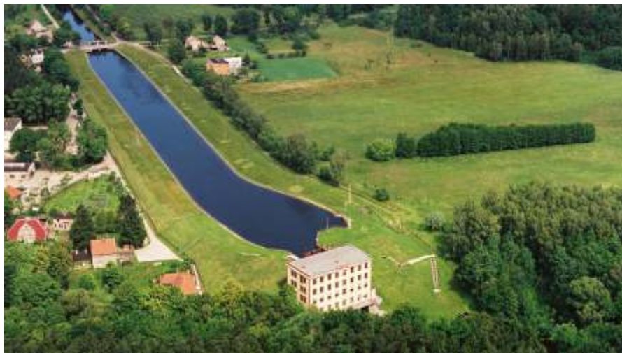
Elektrownia w Gródku. Końcowa część kanału ma formę nasypu, początkowa – głębokiego wykopu (fot. Enea Wytworzenie w Samociążku)
