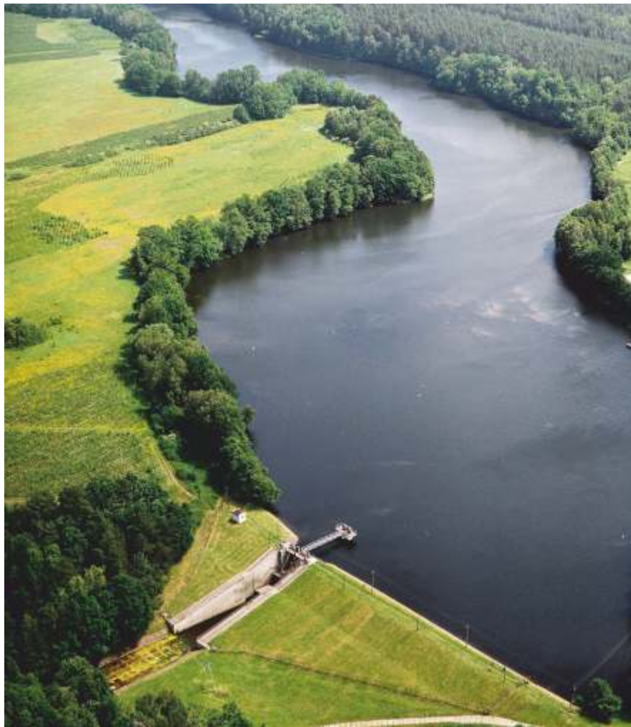
Końcowa część Zalewu Gródeckiego – widoczny wał zapory ziemnej, a w nim przelew burzowy (fot. Enea Wytwarzanie w Samociążku)
