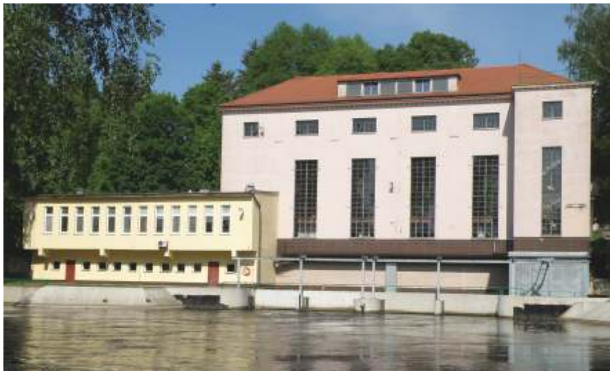
Elektrownia wodna w Żurze od strony dolnej wody (fot. Mariusz Chudecki)
