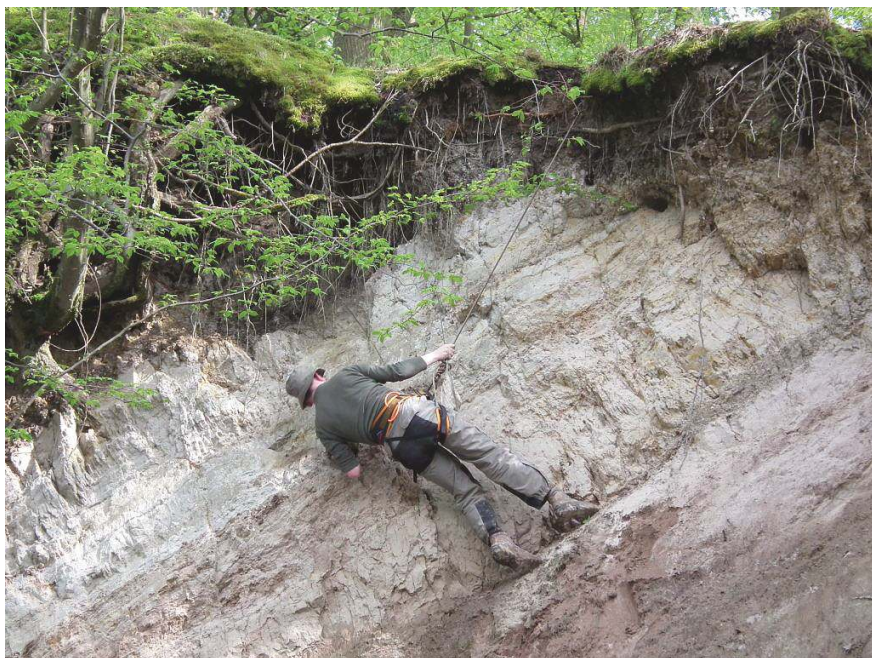
Fot. 13. Kontrola stromej skarpy przy pomocy sprzętu alpinistycznego (RK)
